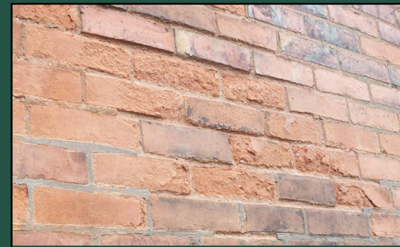
Spalling
